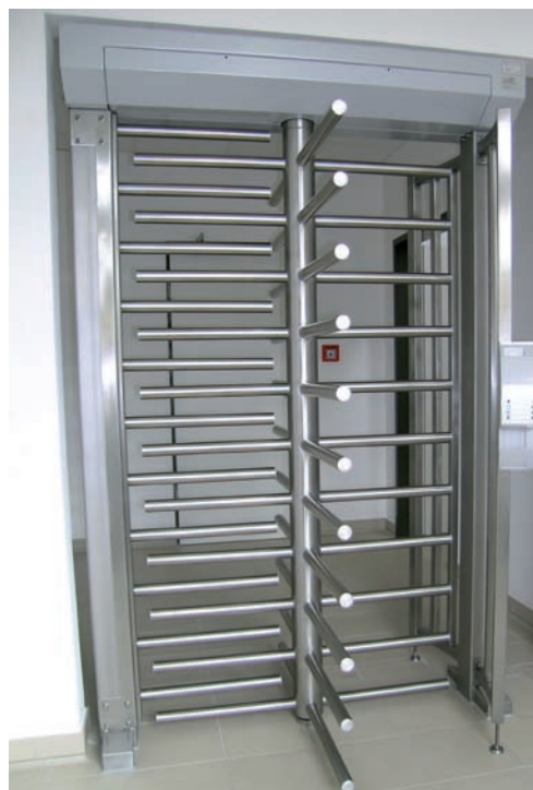
Der Übergang von der Tiefgarage zum Treppenhaus ist oft eine Sicherheitslücke. Sie kann mit Portaldrehsperren adäquat geschlossen werden.
