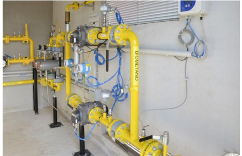
Das Angebot von Endress+Hauser umfasst auch verschiedene Lösungen für die Durchflussmessung mit **Durchflussmessgeräten, Temperatursensoren, Druckmessumformern** und allen für die Volumenberechnung und -korrektur erforderlichen Instrumenten.
